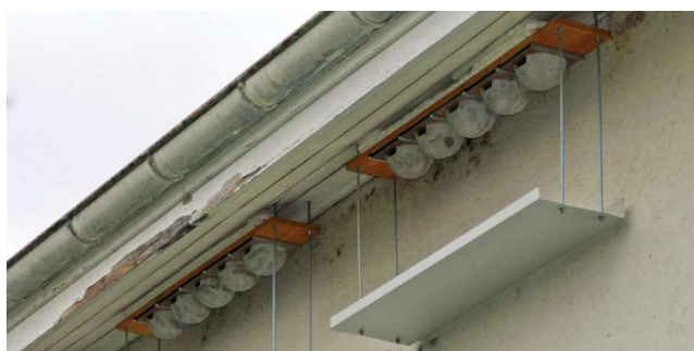
Abb. 14: Zur Schonung der Fassade können Kunstnester mit integrierten Kotbrettern verwendet werden. Bei anderen Systemen und natürlichen Nestern lassen sich Kotbretter mit Winkeleisen oder Gewindestangen befestigen.
