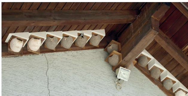
Abb. 19: Befestigung mit Hilfe von Holzkeilen.
